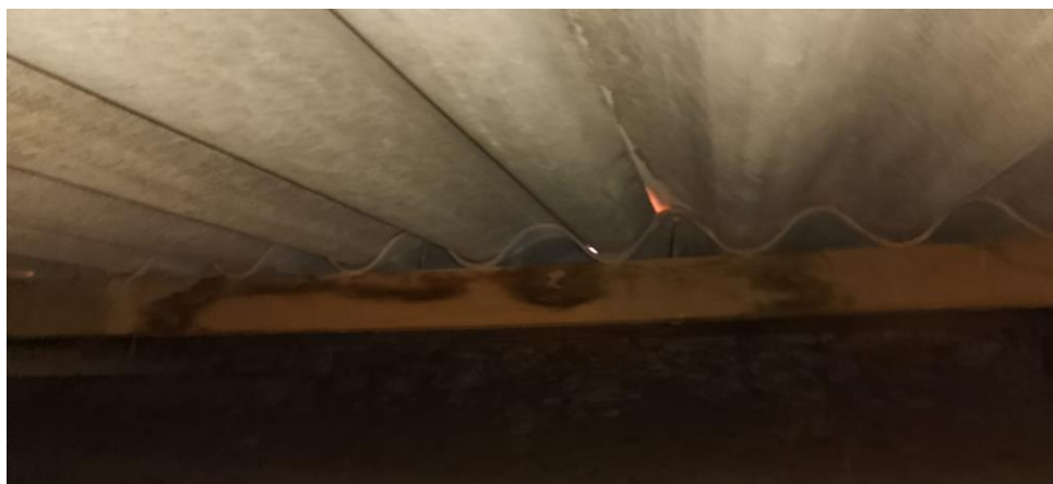
Figura 2 – Pontos de umidade nas terças de madeira
