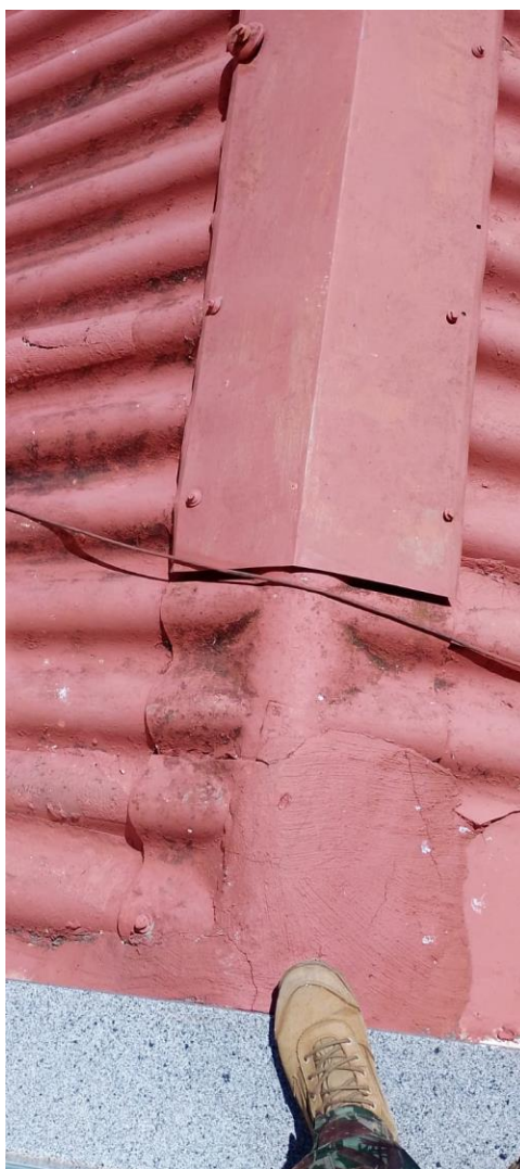
Figura 3 – Reparos inadequados para cumeeira
