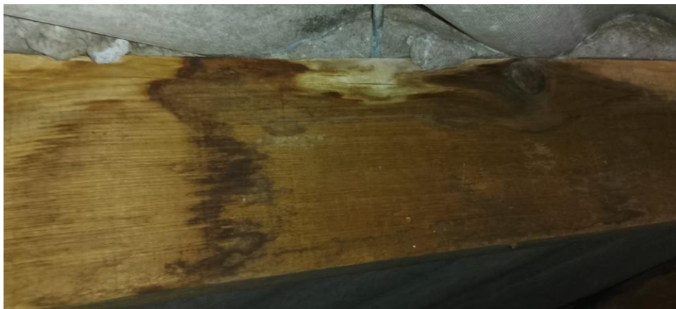
Figura 1 – Ripa do telhamento com umidade
